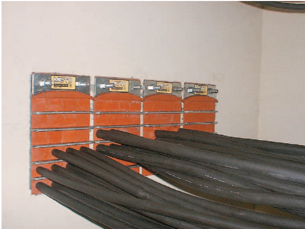
▲地下通路 壁貫通
