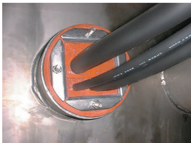
① 貫通フレームを開口部に挿入します。
